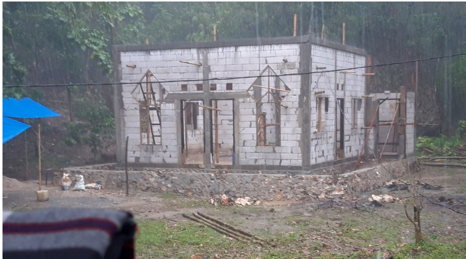
Gambar 4. Hasil pemasangan rabat beton/floor
