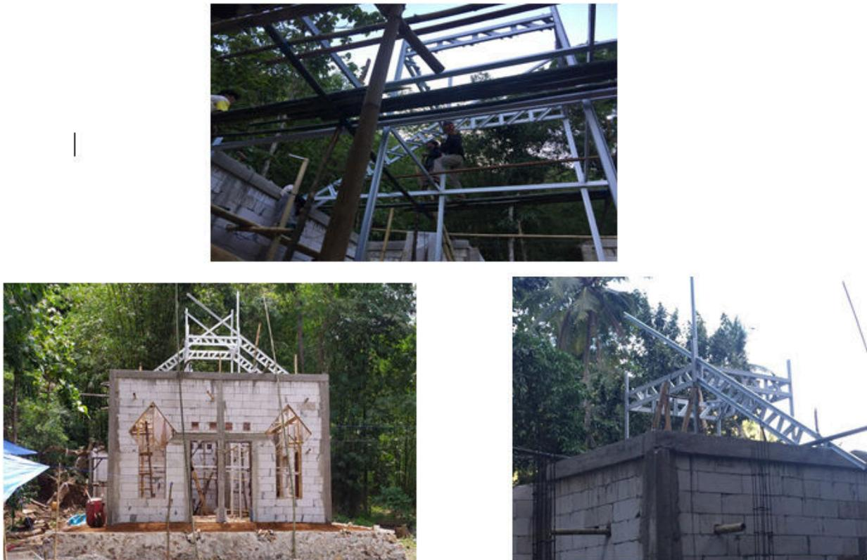
Gambar 4. Dokumentasi Pemasangan rangka atap
