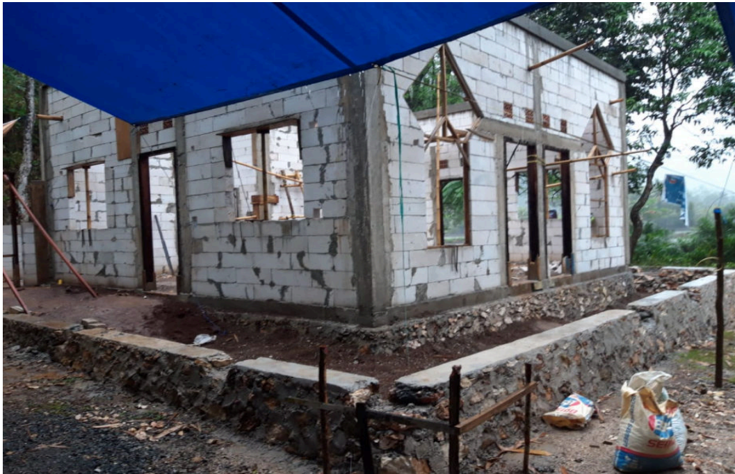
Gambar 4. Hasil Pemasangan Kusen Pintu dan Kusen Jendela
