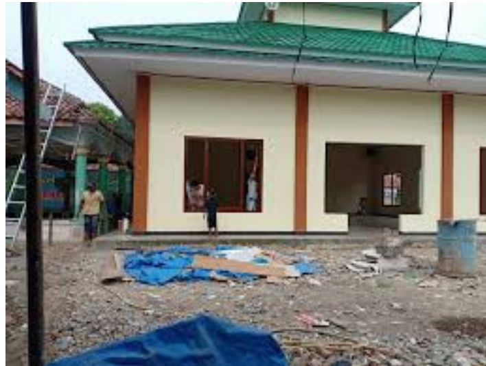
Gambar 3 Pembuatan/pemasangan Kusen Pintu dan Jendela Masjid
