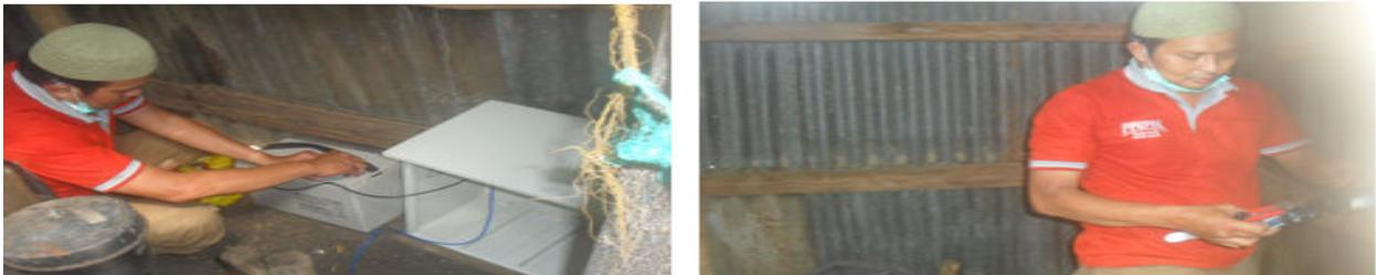
Gambar 3. Merangkai Accu 100 AH dengan komponen dan *Accessories* PLTS
