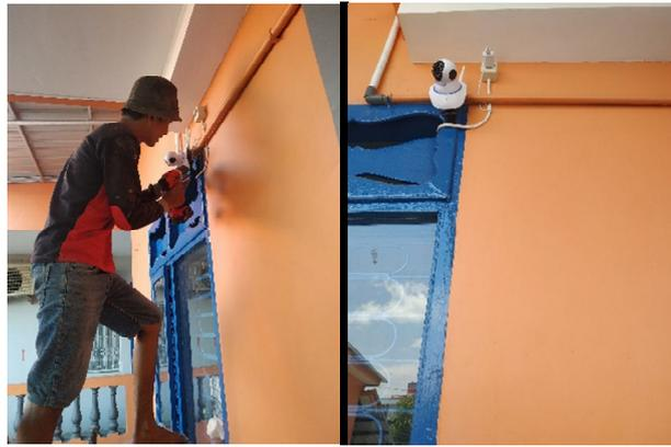
Gambar 7. Pemasangan dan Instalasi kamera CCTV
