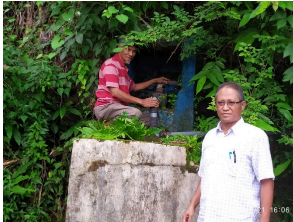
Gambar 1. Kondisi tempat pemasangan pompa yang lama
