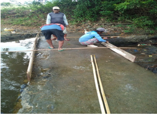
Gambar 11. Pemasangan bekesting
