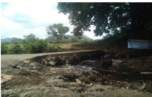
Gambar 15. Pekerjaan pembangunan tinggi jagaan bedung sabodam telah selesai
