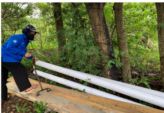
Gambar 7. Pengadaan Pipa Parallon dan papan mall untuk pekerjaan
