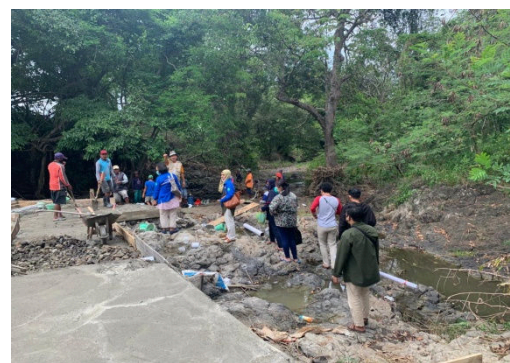
Gambar 14. Pengecoran akhir pekerjaan
