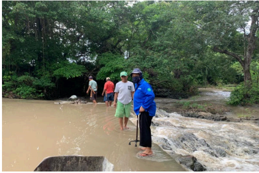
Gambar 5. Membersihkan lokasi pekerjaan
