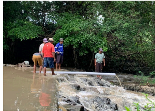
Gambar 12. Pemasangan Pipa Parallon
