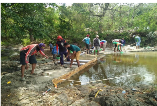
Gambar 13. Pengecoran awal pekerjaan
