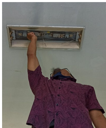
Gambar 4. Pemeriksaan pengawatan lampu FL
