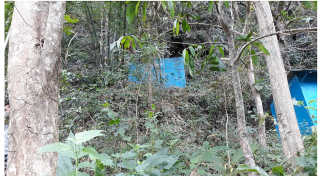
Gambar 1 Bak Penampungan Air Baku
