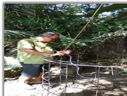
Gambar 4. Pemasangan rangka besi wiremesh
