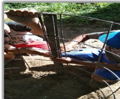
Gambar 4. Pemasangan rangka besi wiremesh
