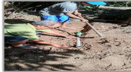
b) Pemasangan pipa saluran
