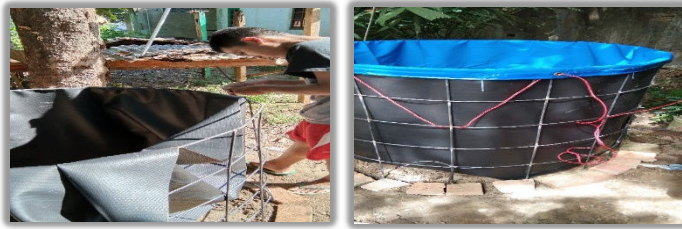
Gambar 5. Pemasangan karet pelindung dan terpal bundar
