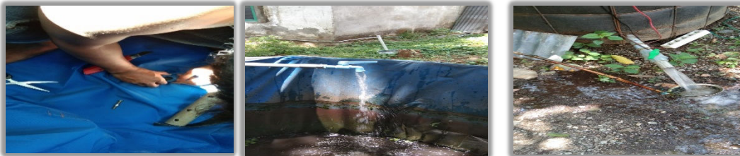
Gambar 6. Pemasangan klem pipa dan pipa saluran pembuangan
