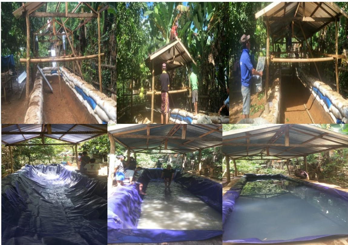
Pembuatan kolam budidaya keong mas berukuran 2x10 meter, dimana pembuatan dimulai dari menggali tanah dengan ke dalam 1,2 meter [6]. Dibuat rangka dari kayu, setelah itu diatapi dengan atap seng. Kolam dilapisi dengan terpal kemudian diisi air dan siap untuk diisi bibit keong mas
