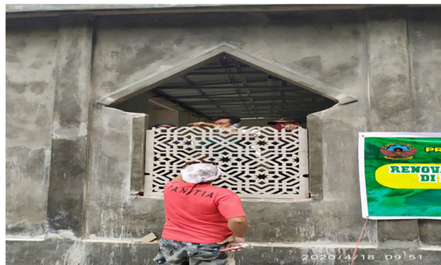
Gambar 4. Pemasangan Panel GRC Krawangan
