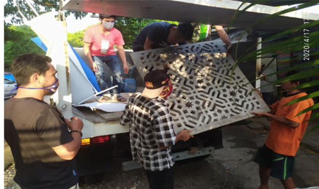
Gambar 2. Proses Pengangkutan Panel GRC Krawangan
