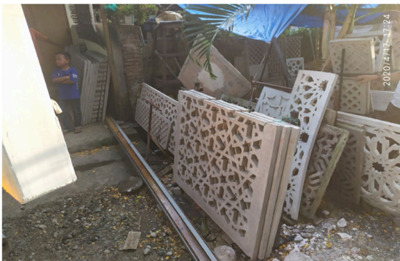
Gambar 3. Persiapan Pengangkutan Panel GRC
