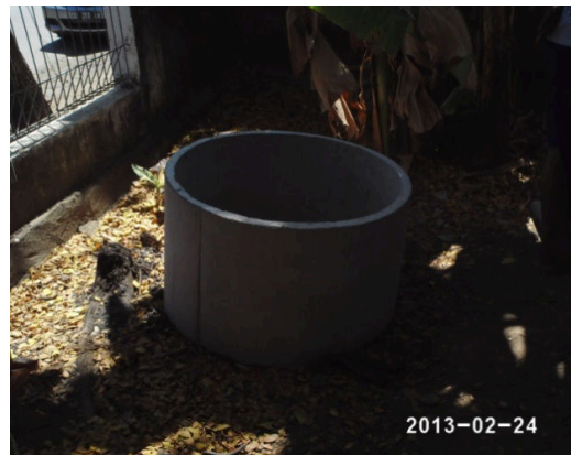
Gambar 1. Demonstrasi pembuatan sumur resapan
