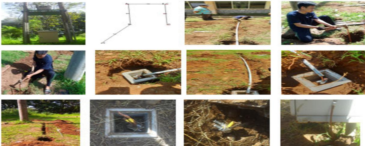
Gambar 1. Proses Pemasangan *Grounding* Pada 5 Titik Lokasi
