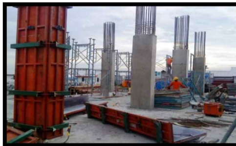
Gambar 3. Bekisting Sistem
