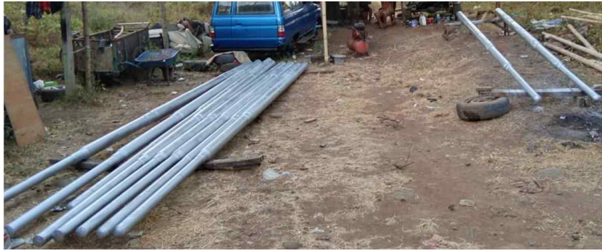
Gambar 3. Pengadaan dan pengecatan tiang listrik
