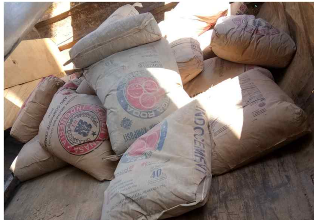
Gambar 4. Pengadaan bahan bangunan
