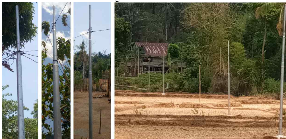
Gambar 6. Pemasangan tiang listrik dan kabel distribusi aliran listrik
