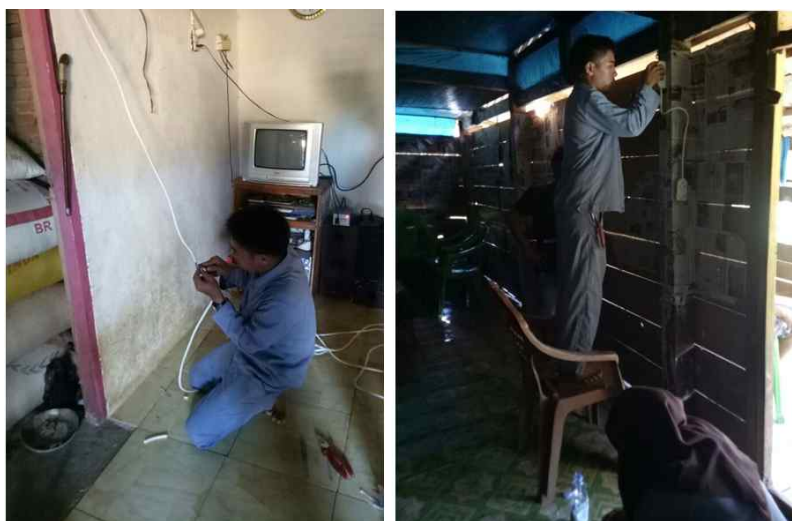
Gambar 7. Pemasangan dan perbaikan instalasi listrik dalam rumah
