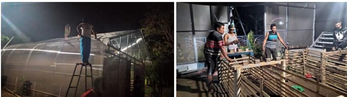
Gambar 3. Kegiatan instalasi bangunan fisik aquaponik. (gambar kiri) pembuatan rumah hidroponik, (gambar kanan) pembuatan kolam terpal rangka bamboo.
