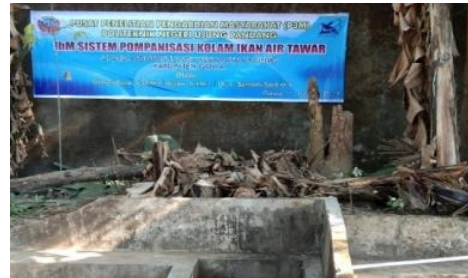
b) Kondisi setelah dibersihkan
