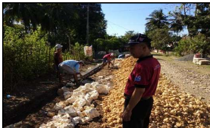
Gambar 4. Penggalian dan pemasangan batu penahan/saluran sisi jalan
