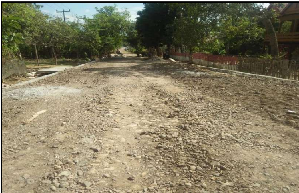
Gambar 5. Pemasangan lapisan sirtu (timbunan pilihan)
