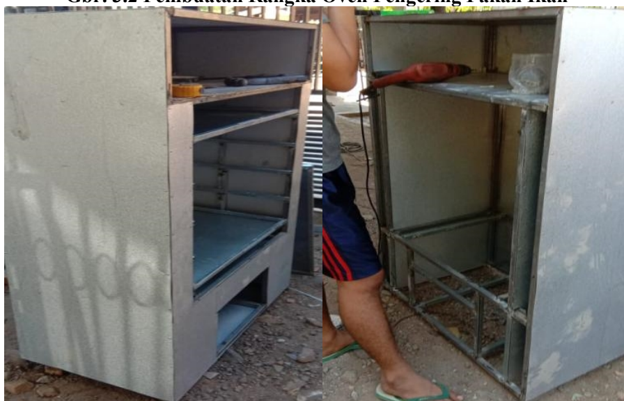
Gbr. 3.3 Pembuatan Dinding Oven Pengering Pakan Ikan
