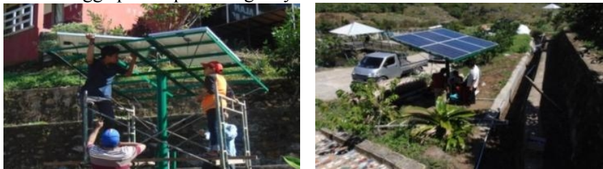
Gambar 7. Penyelesaian Pemasangan PV
