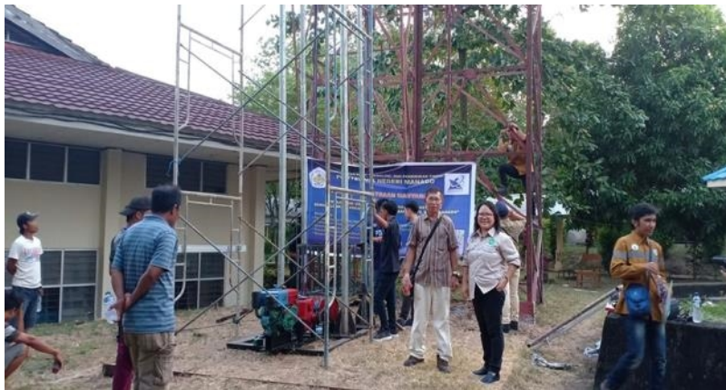
Gambar 5. Pendampingan dan bimbingan teknis pengoperasian dan perawatan mesin pengangkat bahan bangunan
