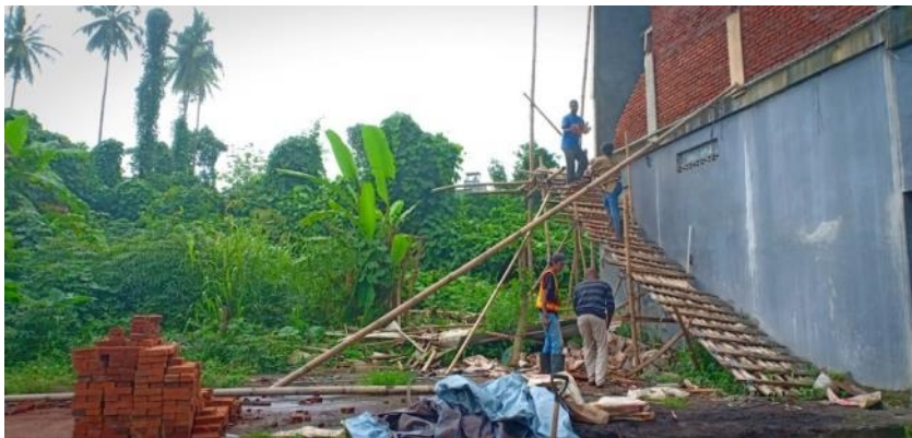
Gambar 2. Metode yang digunakan Mitra: penggunaan tangga sementara dalam memobilisasi bahan bangunan pada lantai dua
