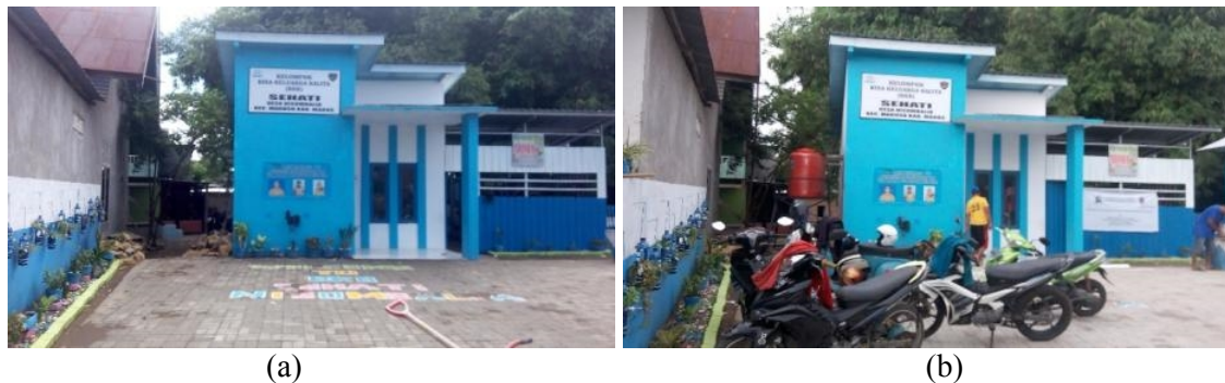
Gambar 3. Lokasi Kelompok Bermain “ADINDA” Dusun Mambue : (a) sebelum dipasang bak penampungan air dan instalasi pipa, (b) setelah dipasang bak penampungan air dan instalasi pipa
