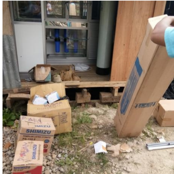
Gambar 1. Pemasangan air gallon pada mitra harapan jaya
