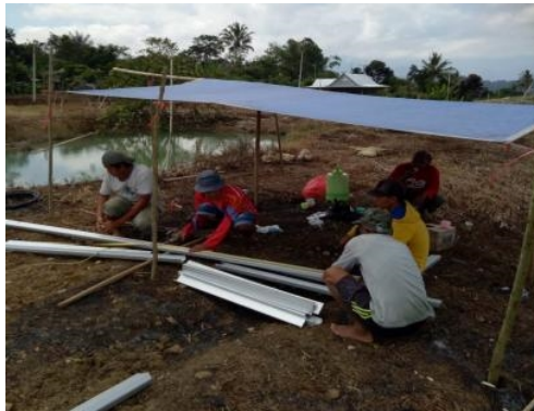
Gambar 3 (a) Pemasangan jaringan pemipaan
