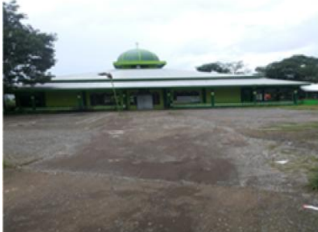
Gambar 1. Kondisi jalan Masjid Ridha
