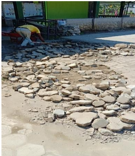
Gambar 7. Pembongkaran jalan paving blok yang sudah rusak
