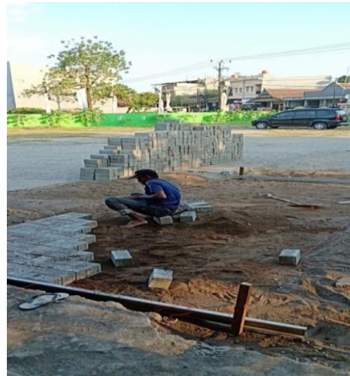
Gambar 8. Pemasangan paving blok
