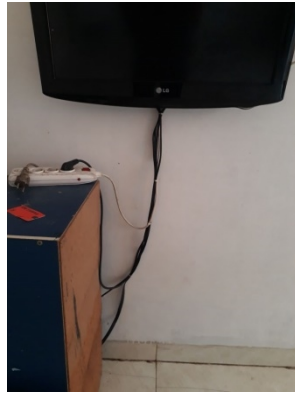
(b) Kondisi Instalasi Perangkat multimedia setelah kegiatan PKM
