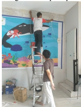
Gambar 8. Pemasangan dan Merapikan Kabel Jaringan Local Area Network (LAN)
