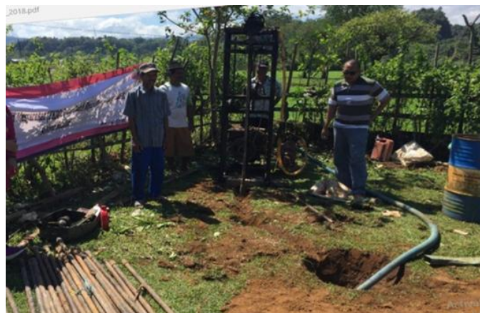
Gambar 3. Pengerjaan awal sumur bor di lokasi PKM
