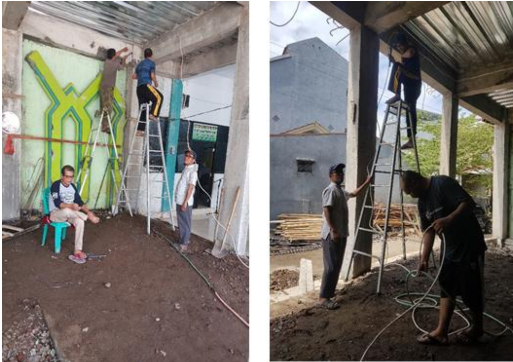
Gambar 2. Praktek pemasangan instalasi listrik
