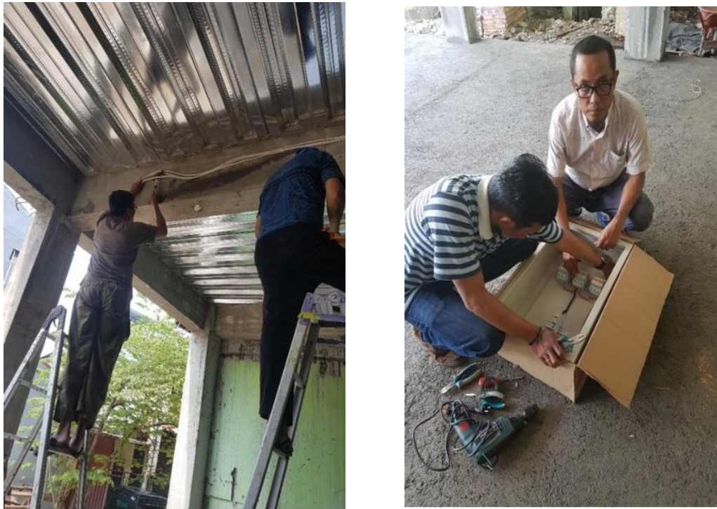
Gambar 4. Pemasangan instalasi listrik oleh warga dan kotak kontrol oleh ketua tim pengabdian
