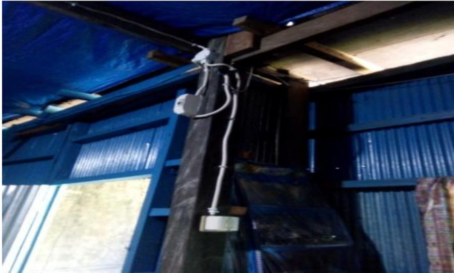
Gambar. 3 Pemasangan MCB dan Stop Kontak
