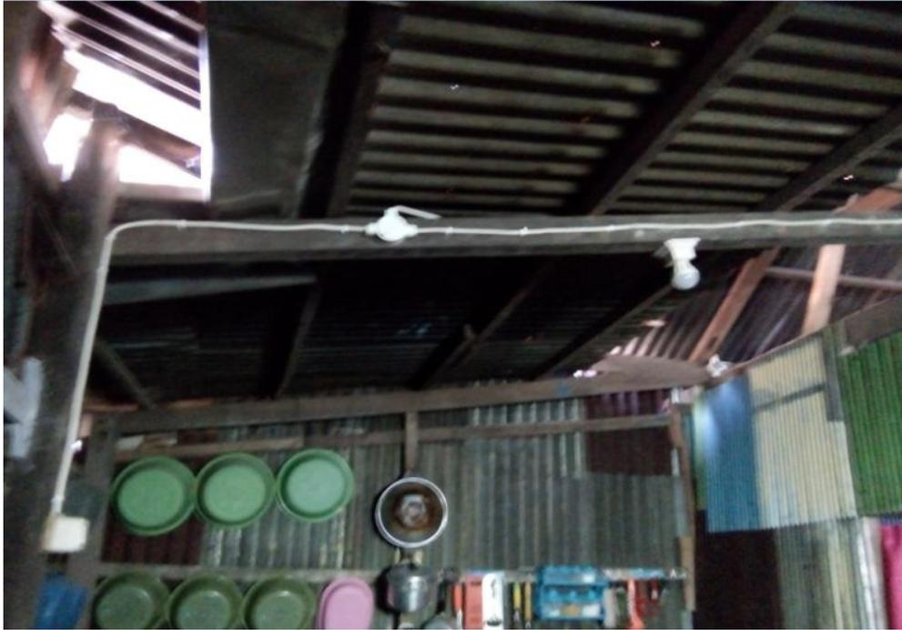
Gambar. 5 Pemasangan Saklar T box Lampu di Dapur
