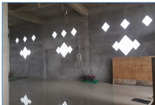
Gambar 1. Posisi kabel listrik yang dapat membahayakan
