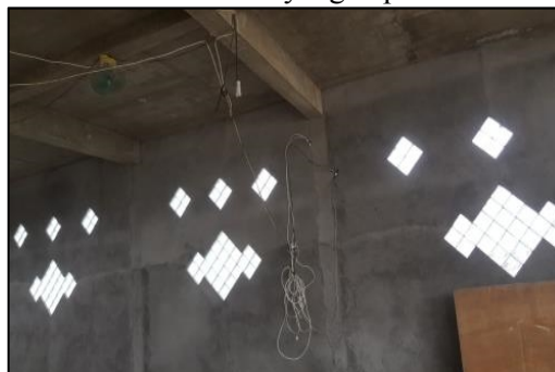
Gambar 1. Posisi kabel listrik yang dapat membahayakan
