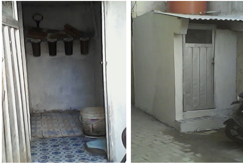
Gambar 6. Lantai, dinding dan atap yang telah difinishing
