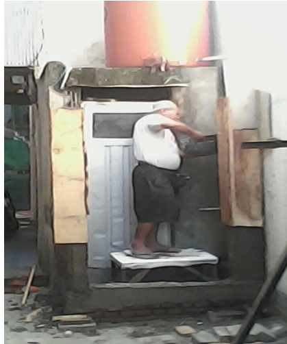
Gambar 4. Pemasangan Kolom dan Dinding
