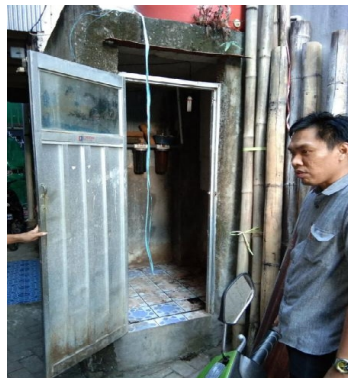
Gambar 1. Kondisi awal MCK
