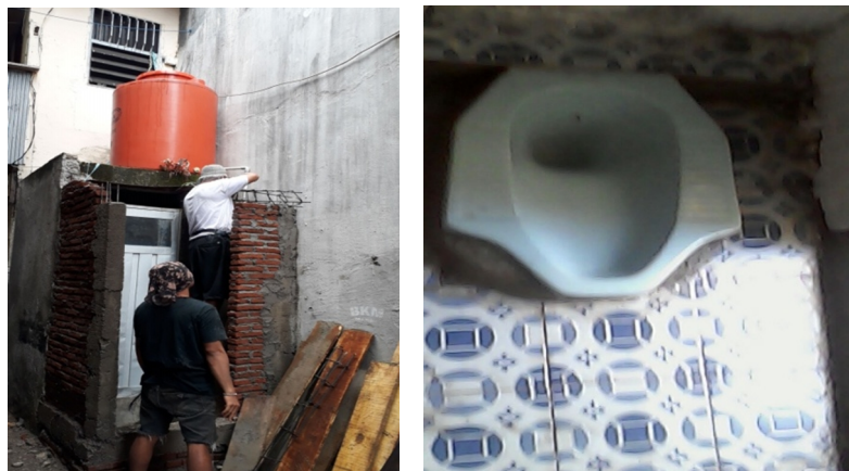
Gambar 5. Pemasangan Kloset dan perbaikan Instalasi perpipaan
