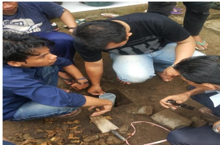
Gambar 7. Pipa lubang resapan biopori diberi penutup berupa dob pipa paralon
