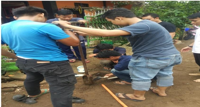
Gambar 4. Penggalian lubang resapan biopori dengan alat hand bor
