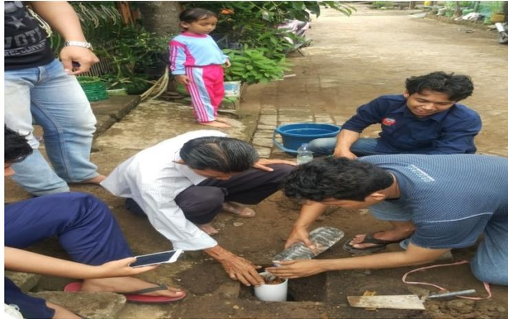
Gambar 6. Pemasukan air ke pipa lubang resapan biopori
