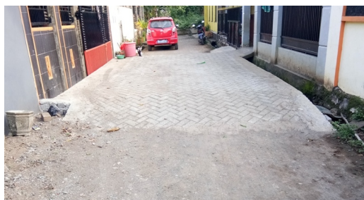
Gambar 3. Permukaan Jalan yang telah dipasang paving block
