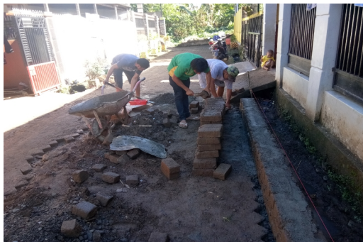
Gambar 2. Pemasangan Pondasi sebagai acuan Elevasi permukaan Jalan
