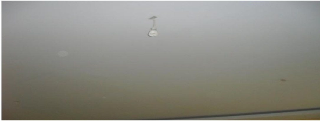
Gambar 7. Pemasangan beberapa Fitting Lampu
