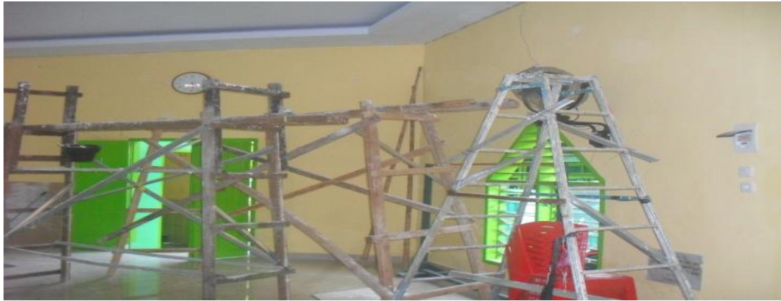
Gambar 4. Pemasangan Instalasi Listrik Secara In Bow
