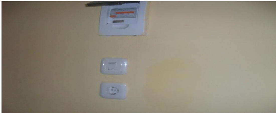
Gambar 5. Pemasangan PHB, Stop Kontak, Saklar Seri Secara In Bow
