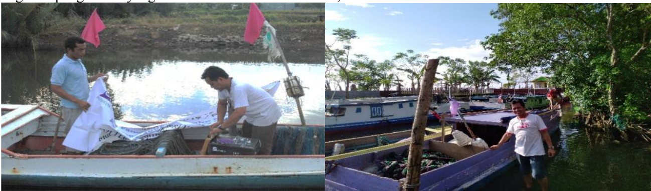
Gambar 2. Kegiatan pelatihan instalasi PLTS Perahu Nelayan di Desa Pancana Kab. Barru
