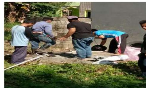
Gambar 6. Pemasukan pompa ke dalam lobang sumur
