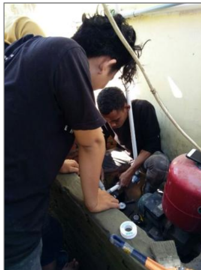
Gambar 2. Pemasangan instalasi pipa air
