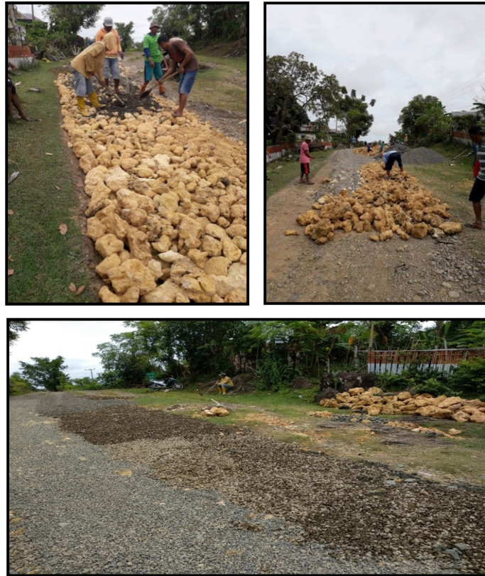
Gambar 3. Foto-foto pelaksanaan perbaikan jalan
