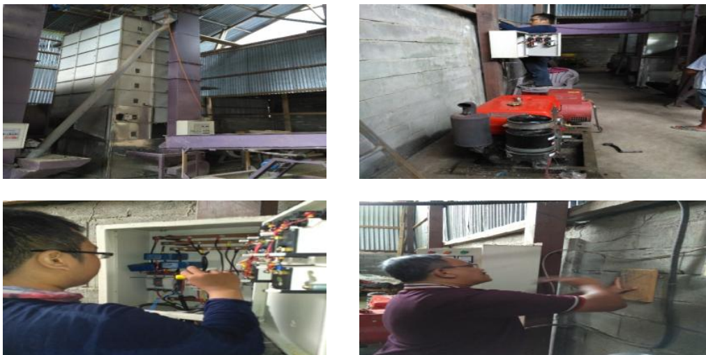
Gambar 3. Kegiatan pemasangan instalasi listrik di Pabrik pengilingan gabah
