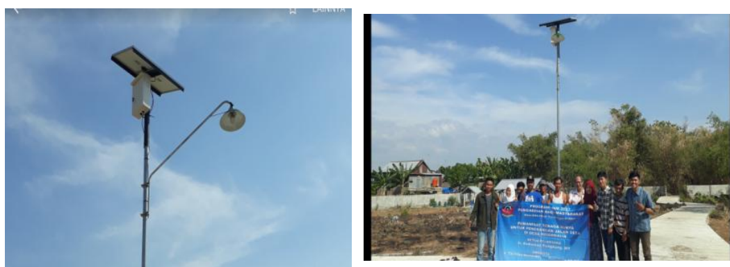
Gambar 10. Hasil Pemasangan Penerangan Jalan PLTS
