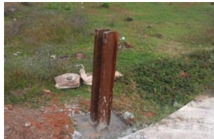
Gambar.5 Petunjuk Pembuatan Konstruksi dudukan Tiang
