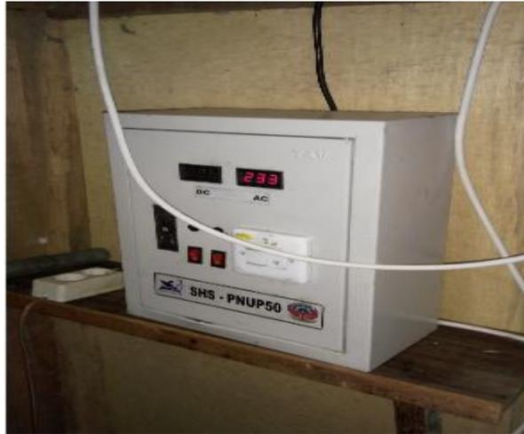
Gambar 5 Kontrol Box menunjukkan output tegangan 233 volt
