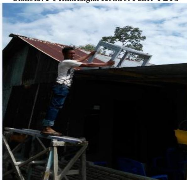
Gambar. 4 Pemasangan Panel Surya di Atap rumah
