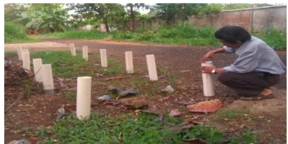
Gambar 6. Pemasangan penutup pipa paralon dengan dob pipa paralon
