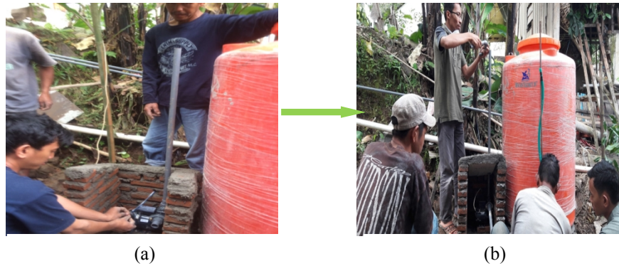
Gambar 4. Pembuatan komposter (a). pemasangan pompa, (b). Uji coba sirkulasi biourine dengan pompa
