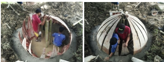
Gambar 4. Pengecoran Reaktor
