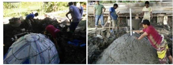
Gambar 6. Pengecoran Kubah
