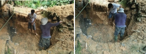
Gambar 2. Penggalian Lubang Reaktor
