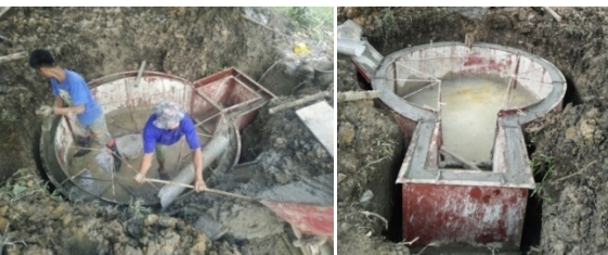
Gambar 4. Pengecoran Reaktor
