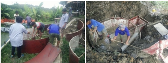
Gambar 3. Pemasangan Mal Lubang Reaktor
