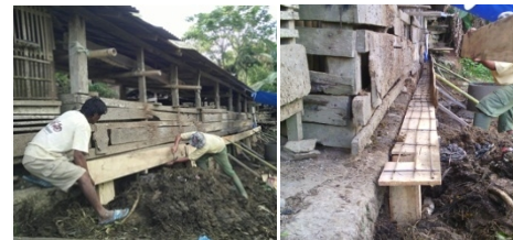
Gambar 8. Pengerjaan dan pengecoran saluran limbah ternak
