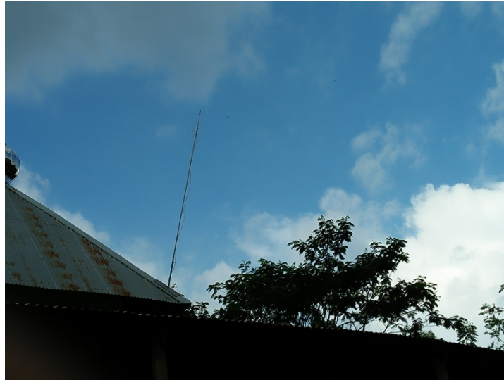
Gambar 4. Hasil pemasangan instalasi penyalur petir
