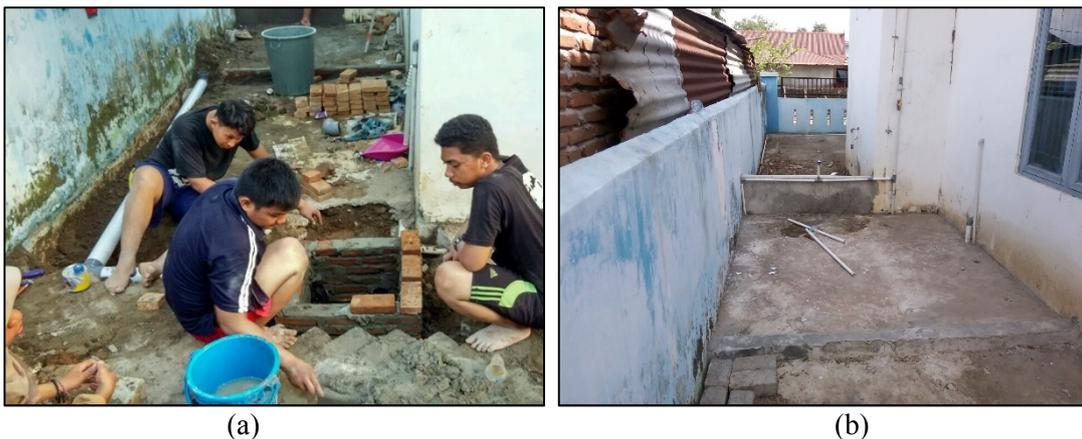
Gambar 2. (a) Pembuatan tempat cuci dan bak kontrol di belakang Pustu, (b) Tempat cuci selesai dibuat
