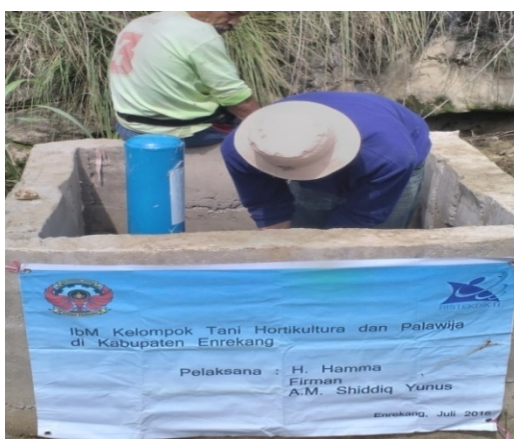
Gambar 3. Pompa dan pipa intake setelah terpasang
