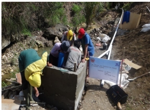
Gambar 3. Pompa dan pipa intake setelah terpasang
