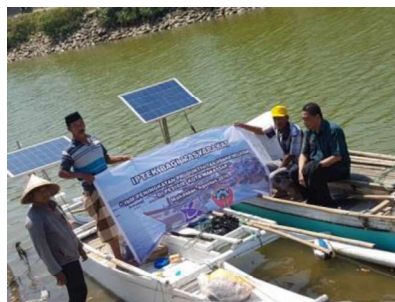
Gambar 26. Pemasangan Solar Cell
