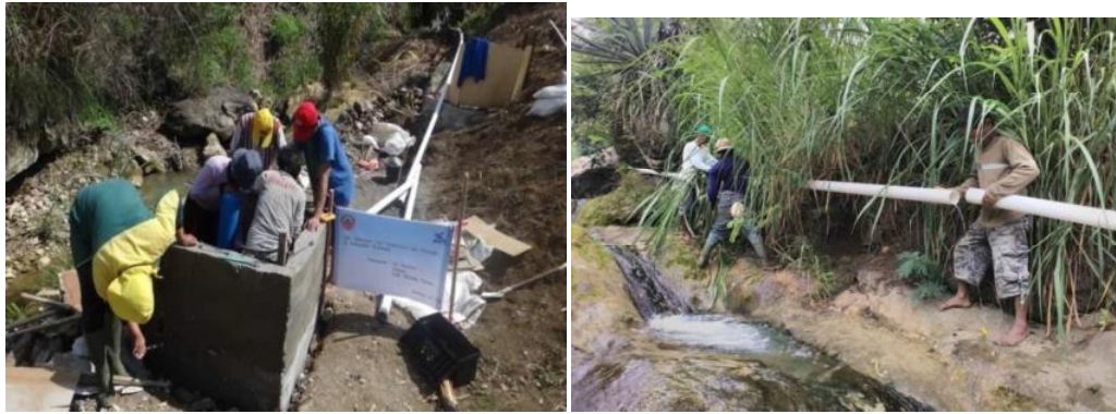
Gambar 3 Pemasangan pompa hidram Gambar 4 Penyambungan pipa intake
